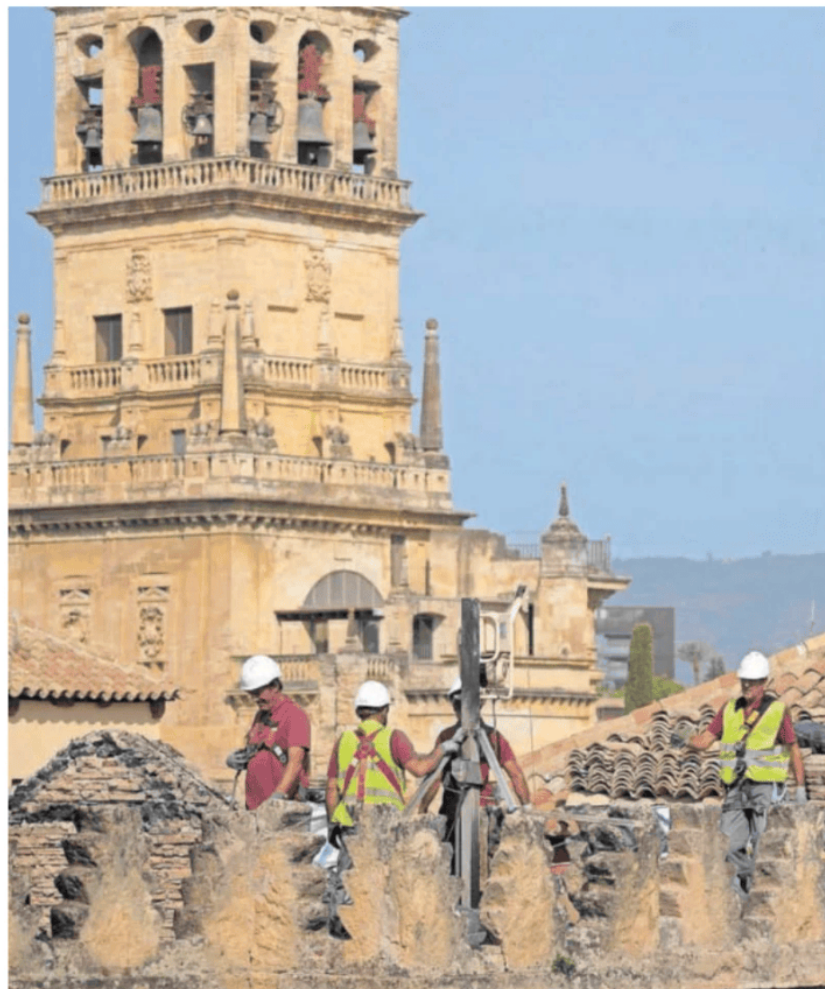
Operarios de la Mezquita trabajaban el martes en los tejados afectados por el incendio. CHENCHO MARTÍNEZ
